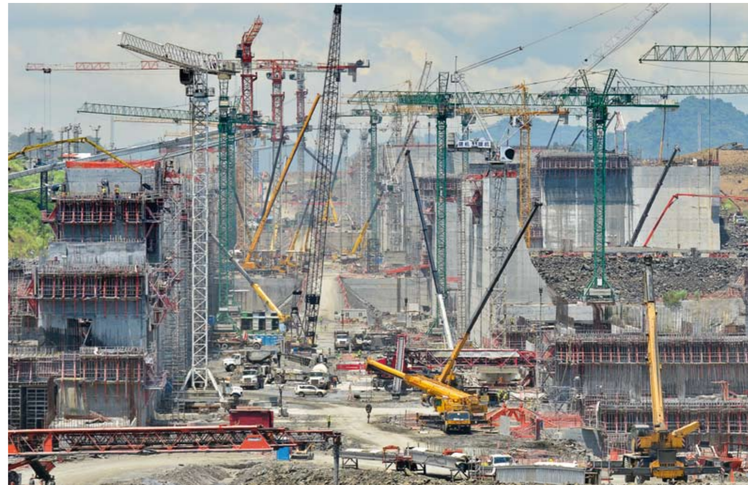
GIGANTOMANIE. Kräne soweit das Auge reicht: Für die Errichtung der neuen Schleusenanlagen werden 4,3 Millionen Kubikmeter Beton benötigt
