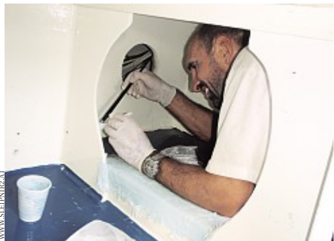
Notreparatur: Wolfgang Wirtl beim Abdichten der Bruchstelle
